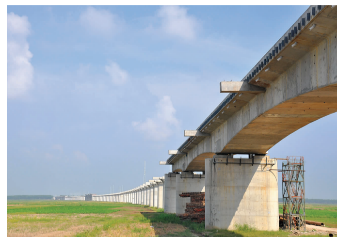
8月15日上午,正在建设的连盐铁路新沂河特大桥施工现场,一座座桥墩蔚为壮观。
