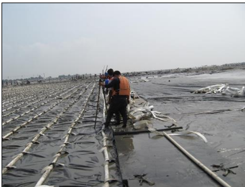
图 2.3-2 人工插打排水板
