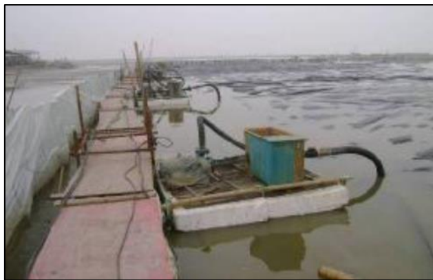
图 2.3-6 真空泵放置
