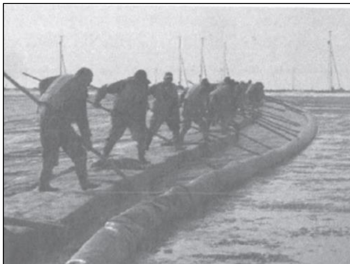
图 2.3-1 人工铺设第一层编织布
